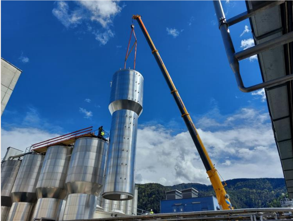
Installation des neuen Laktosetanks in Kundl (Copyright: Spiegeltec)
